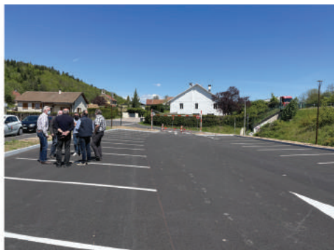
Parking de 50 places rue de Turenne
